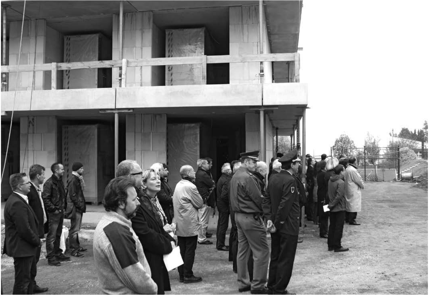
Richtfest für das Studentenwohnheim „Am Postkeller“ in Weiden
